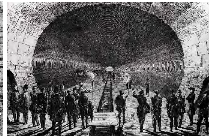
Egout collecteur construit sous le boulevard de Sébastopol à Paris, gravure du Monde Illustré (1858)
